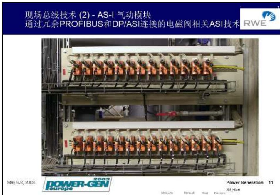
在上图中，总线电缆是水平的黄色电缆。这个电缆由电源线和数据线组成。显而易见利用总线技术使得施工安装变得简单：总线电缆可以简单的接入气动阀控制模块基站，模块再插入到基站即可。连接电缆不需手动剥线可直接接入控制模块，也就是说不再需要传统的接线方式。
