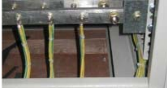
图 1-10 二根线接一个端必须可靠
