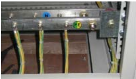
图 1-3 零线排组与保护接地排组
