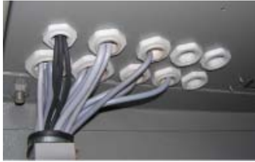
图 1-8 变频控制柜外加塑料护套
