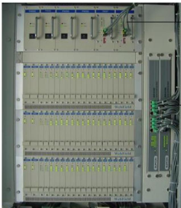
→ 主控卡的 SCnet II 网络端口，通过网线连接到下面的 SCnet II HUB 上，实现与操作站或工程师站的通讯连接。
