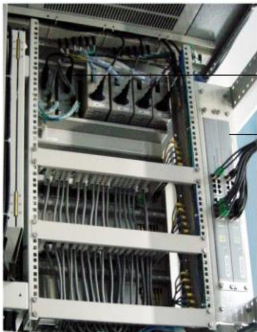
主控卡的 SBUS 网络端口, 通过网线连接到下面 SBUS HUB 上, 实现主控卡和各机笼的连接。
