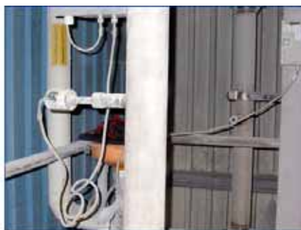
电厂脱硫石灰粉流量测量 DN80 管道, 20-120 , 1-3T/h
