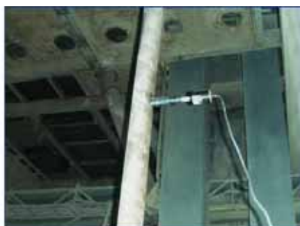
电厂锅炉给粉流量测量 DN75 管道, 80 , 4T/h
