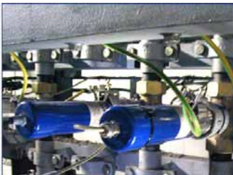
塑料颗粒管道堵料检测 (20Bar 压力, 通过高压适配器隔离安装)
