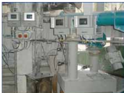
氧化铝粉流量测量 DN100 管道, 常温, 3T/h
