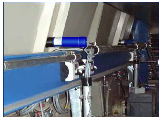
塑料颗粒仓料位检测（多点测量）
